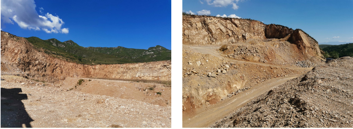
照片 4-1 采场边坡现状
