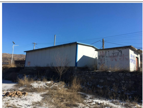
照片 4-3-2 神堂湾村供水井
