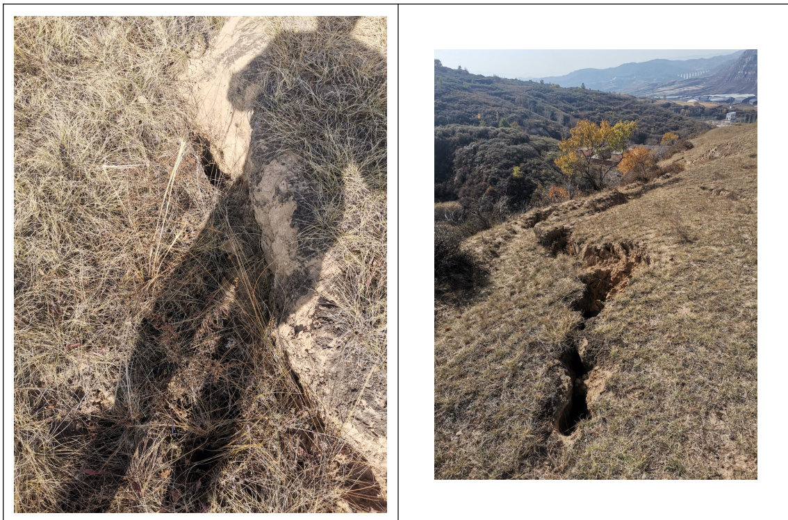
照片 4-1-1 现场调查地裂缝
