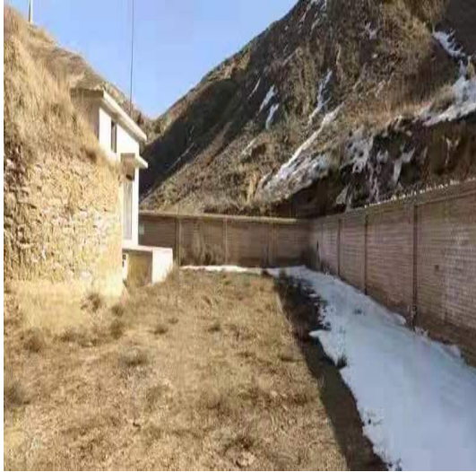
照片 4-3 废炸药库
